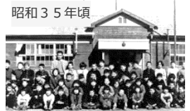
旧校舎(現西堀球場)
